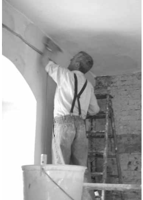
Originalton Pfarrer Bezzel am Gerüst: „Sklavenarbeit!“
